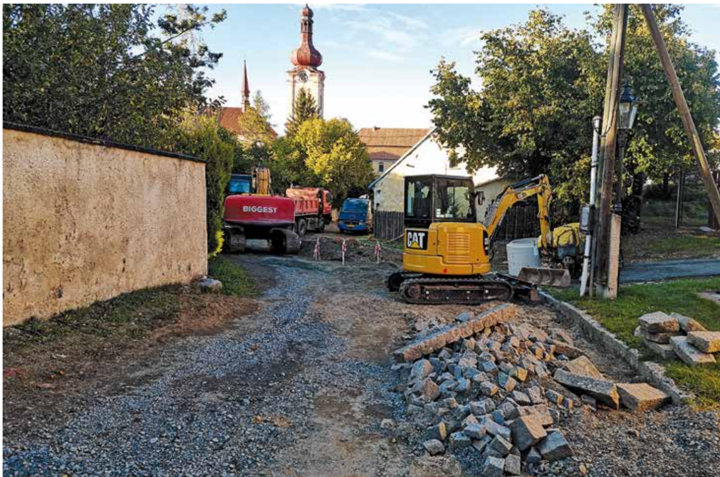
Pokládka kanalizace v Přesaničské ulici, foto Pavel Motejk
