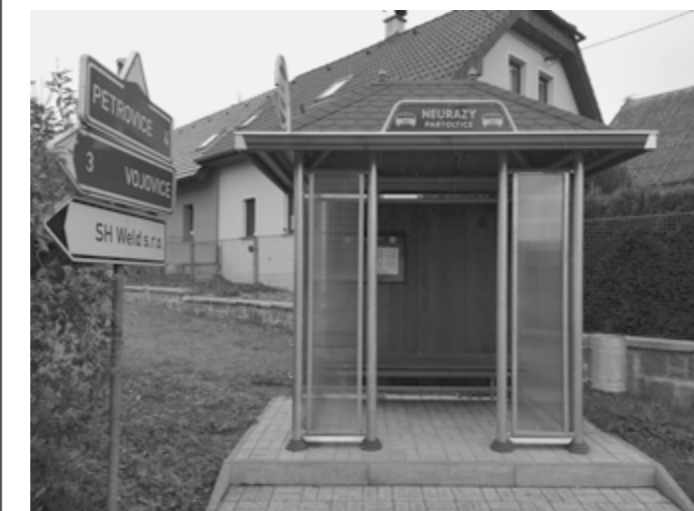
čekárna v Partolticích, foto Pavel Motejzík
